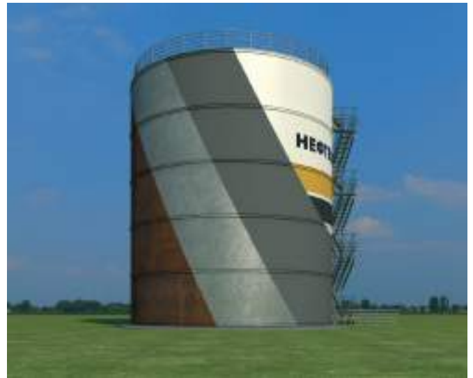
Антикоррозионные системы холодного цинкования
