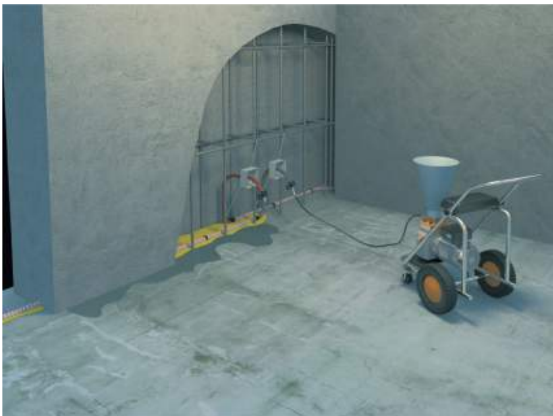
Прокачка перфорированного шланга инъекционными системами
