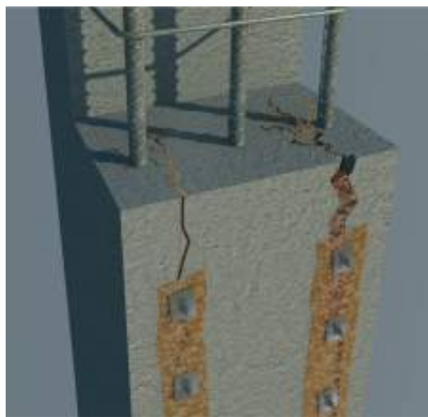
Применение клеевых инъекционных составов
